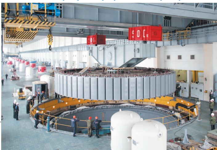
Установка ротора на гидроагрегате №12 на Красноярской ГЭС
